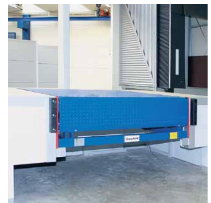
Il sistema Crawford Unidock 612 viene posato nella fossa.
