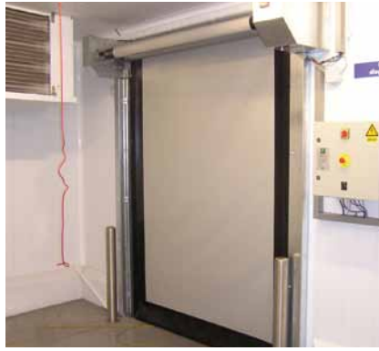
Brama szybkobieźna Crawford 9110 FR Przeznaczona do mroźni, polepsza przepustowość, minimalizując jednocześnie wahania temperatury. Maks. rozmiar (W×H): 4500×4500 mm Prędkość działania: Otwieranie: do 2.4 m/s Zamykanie: 1.2 m/s
